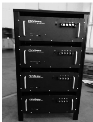
图 1 通信基站常用 100Ah 梯次电池实物图
